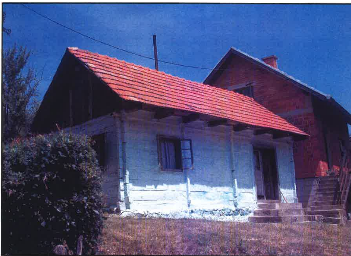
DOMOVEC - tradicijske kuće uz cestu proljeće 2005
