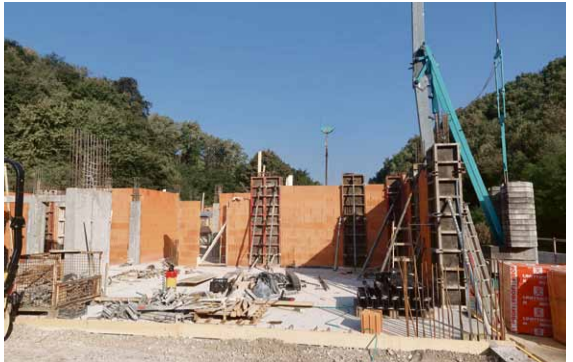
Gradnja dječjeg vrtića dobro napreduje
