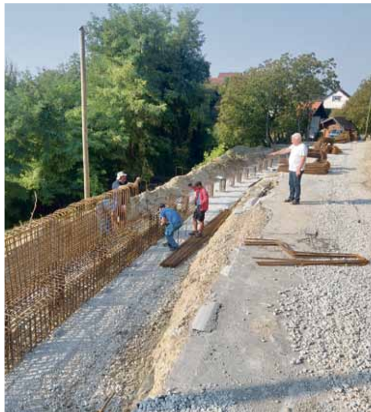
Radovi na sanaciji klizišta
